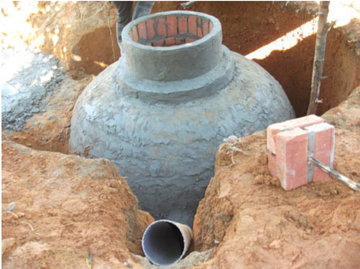
Hier wird die Kaverne für die erste Anlage in Binh Thanh in die Erde gesetzt
